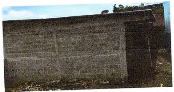
Foto 4: Construcción de un aula.
