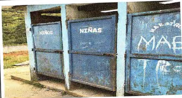
Foto 5: Remozamiento de una de las puertas del baño de niñas.
