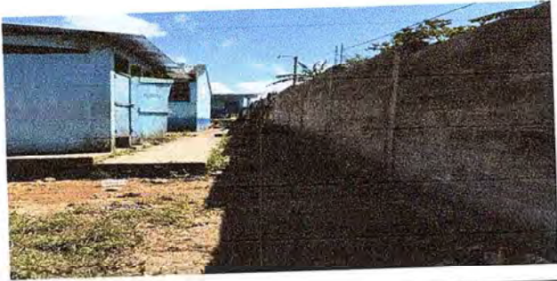
Foto1: Circulación completa con bloques del predio del establecimiento.
