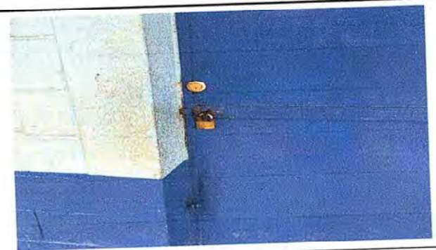
Foto 6: Instalación de chapas y argollas para dirección y bodega del establecimiento.
