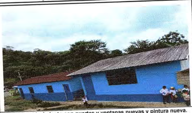
Foto 2: Establecimiento con puertas y ventanas nuevas y pintura nueva.
